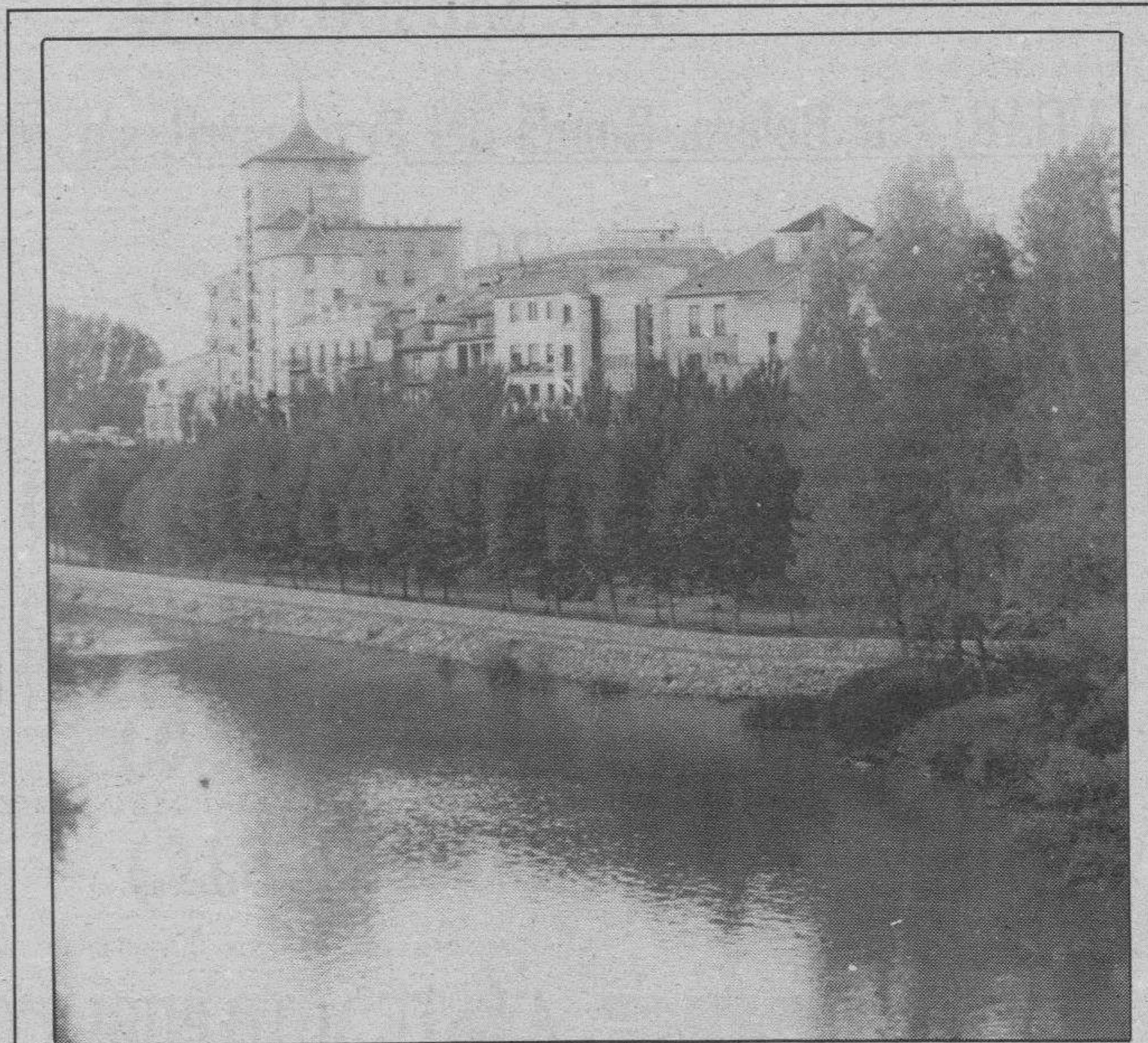
Un muro de contención para el Duero. Hace unos días hablábamos de las riberas de los tres ríos que atraviesan Aranda anunciando que los proyectos de su adecentamiento ya se han presentado en la Junta, organismo del que se espera recibir ayudas. Mientras, se realizan algunas actuaciones por parte del Ayuntamiento arandino como ésta de la margen izquierda del Duero, lo que se ve desde el puente de la antigua Nacional 1, que, a nuestro juicio, está quedando fenomenal con esa construcción de un muro de contención a base de hormigón en la base y piedras. Las obras están ya adelantadísimas y esperamos que el resto de los proyectos se cumpla también cuanto antes, por el bien de nuestra ciudad.
