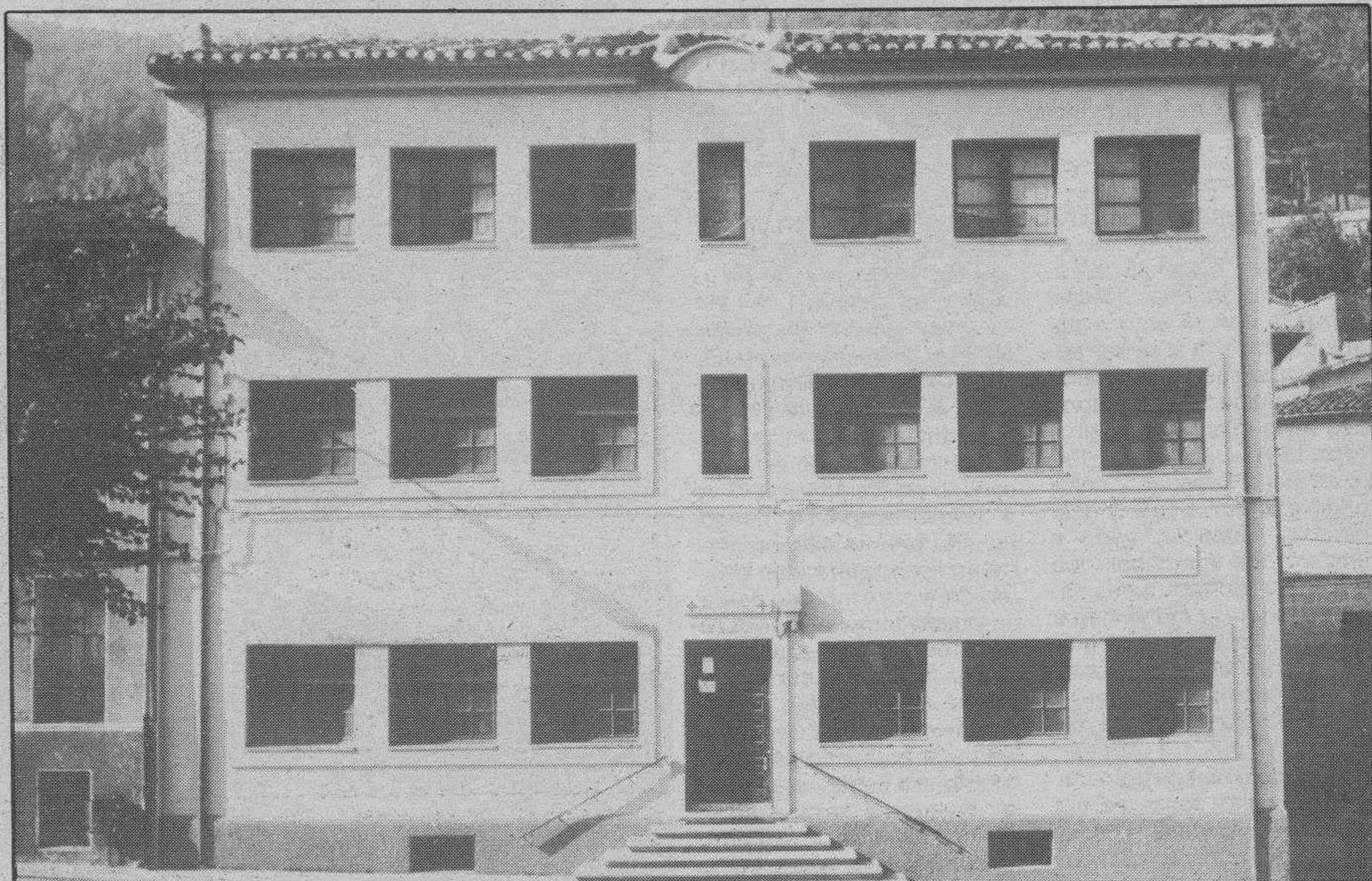
Centro sanitario en Pradoluengo. Foto Luis.
