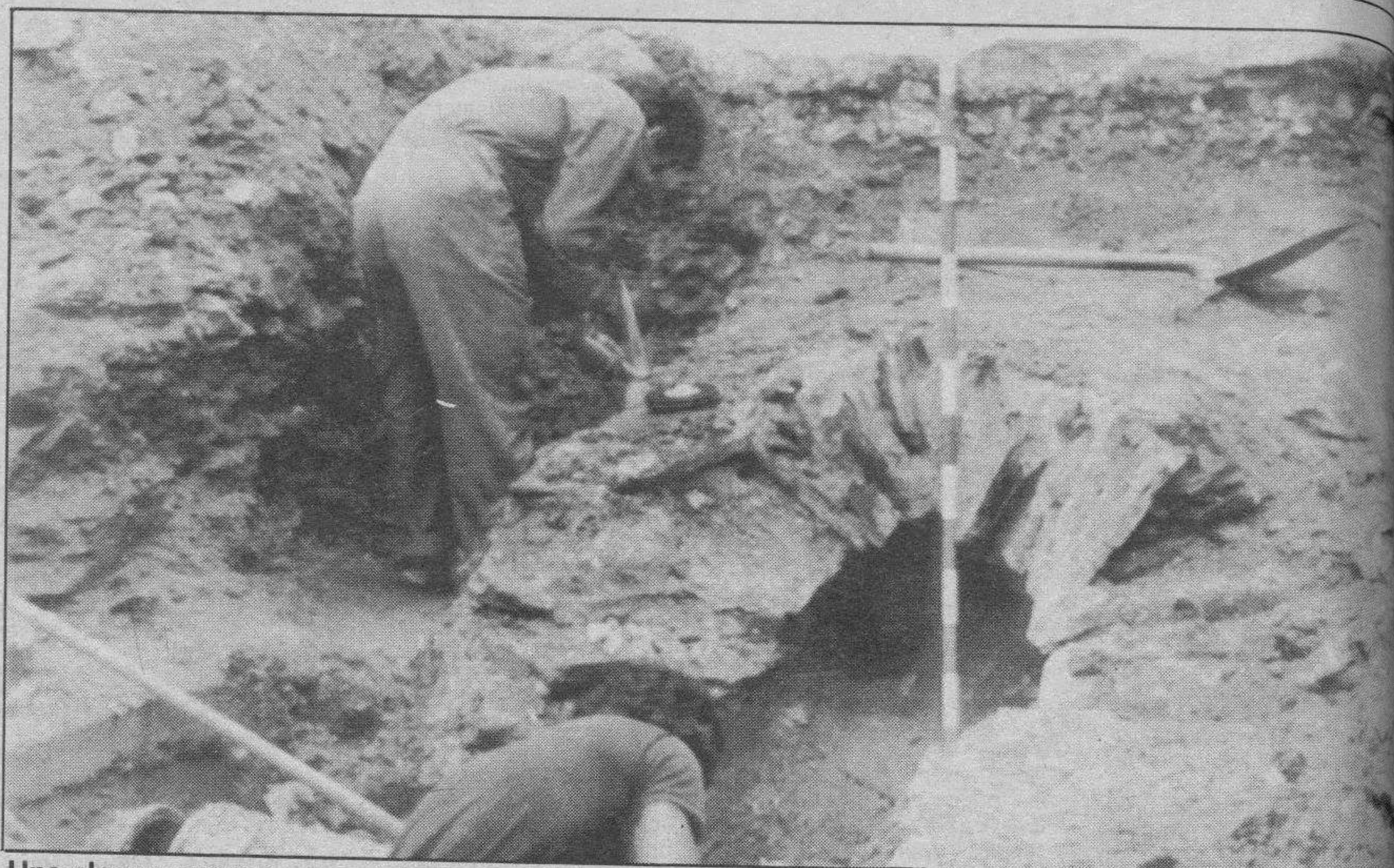
Una cloaca romana que unía las puertas de la muralla de San Pedro con la de Santiago, en Lugo, ha sido descubierta al levantar el pavimento de la calle de la Reina.
