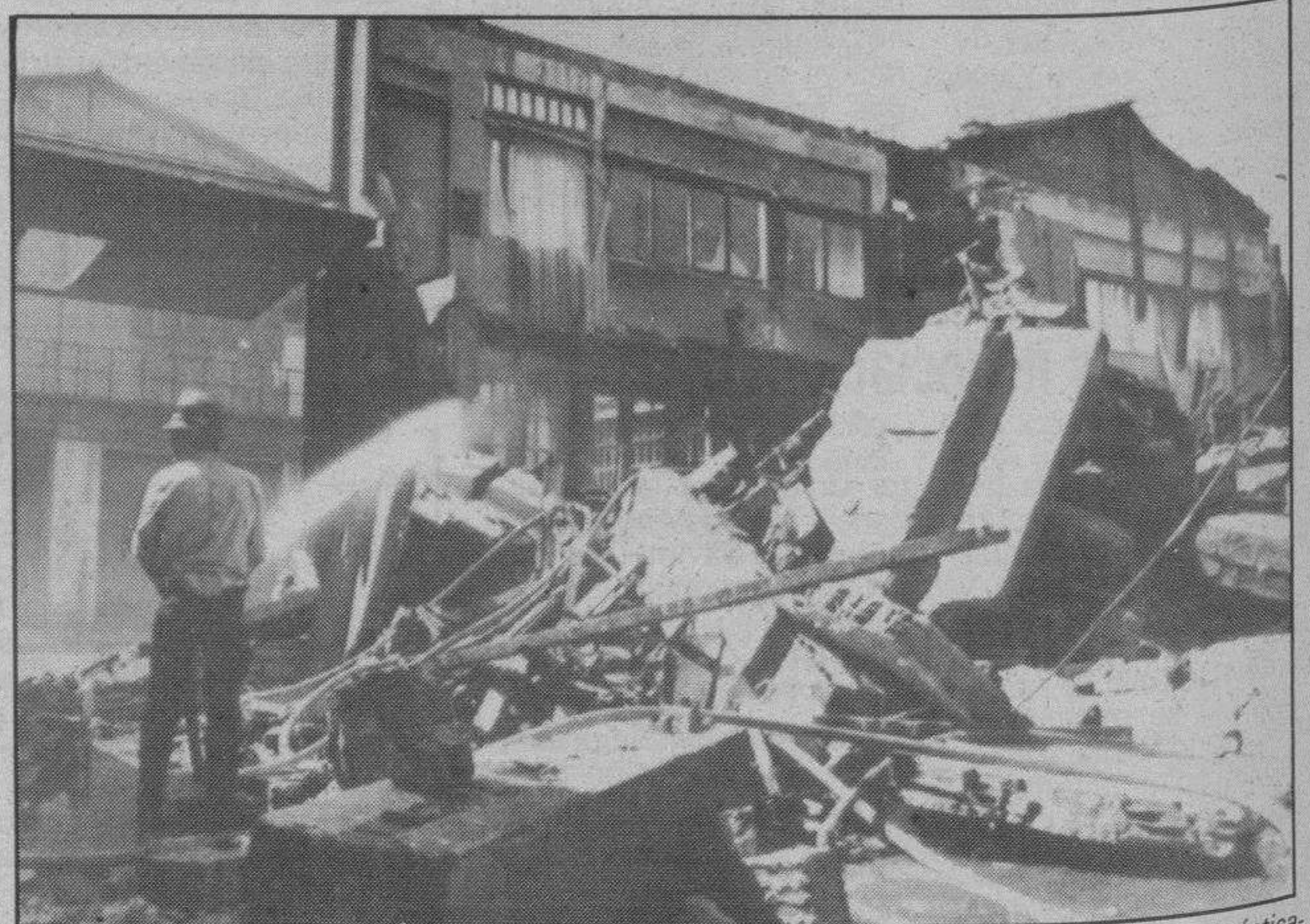
La industria de barnices y pinturas «Ressyl», situada en el barrio de Sant Andreu, resultó prácticamente destruida como consecuencia de un incendio. En la foto, los bomberos durante el trabajo de extinción. Efe.
