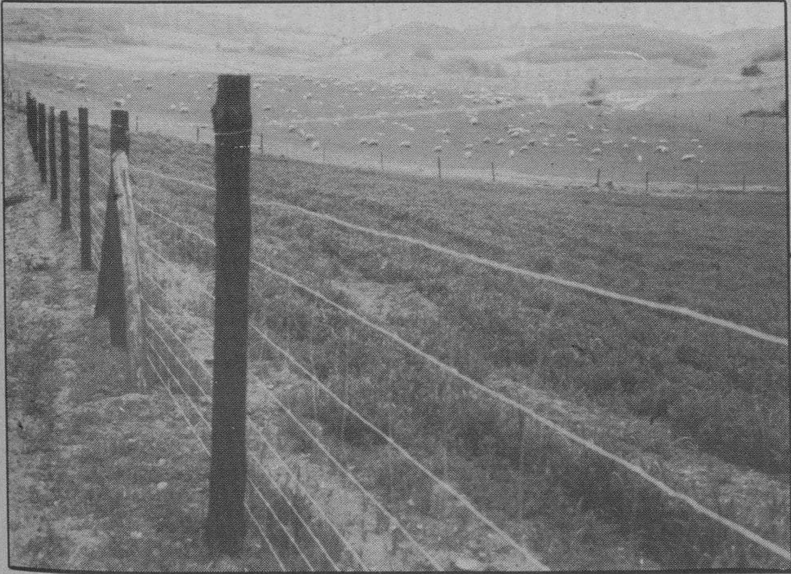
Instalación de cercado en la finca Fuenteblanca
