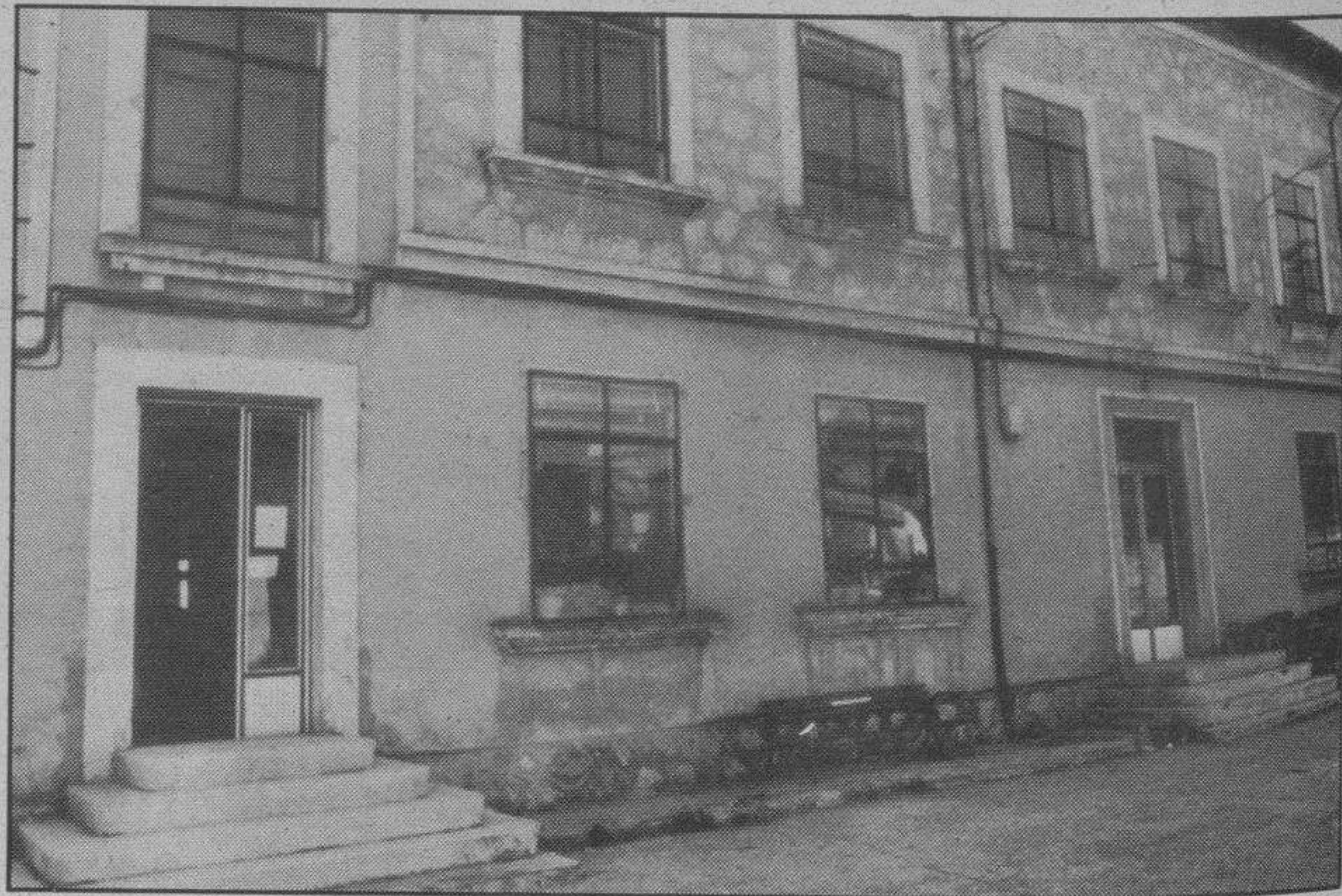
Los jóvenes del campo de Villafranca trabajan en la recuperación de parte de este edificio para albergue juvenil.
