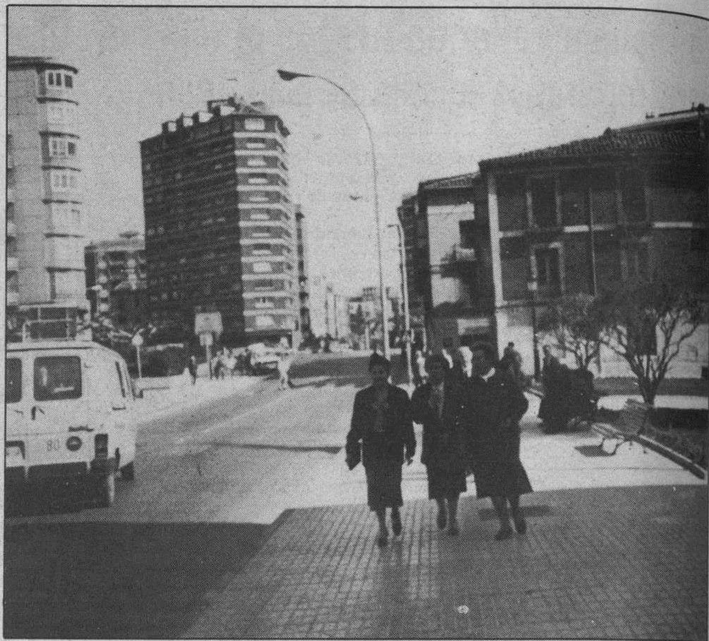
El ayer y el hoy. — Mucho va cambiando la fisonomía urbana del centro histórico de la ciudad. Pero aún va a cambiar más, como consecuencia de las obras, ya iniciadas de la Ronda del Ferrocarril. Años atrás, los constructores anticipándose a los acontecimientos comenzaron a construir a los lados de la desaparecida vía ferroviaria, como puede observarse a la izquierda de la imagen, mientras que a la derecha pueden verse viejas edificaciones, que corresponden a la Plaza de Cervantes que, probablemente y en razón a su mal estado y a la especulación del suelo están condenadas a desaparecer. Por otro lado, este tramo que vemos de la calle Real Allende tendrá que ser rebajado algo así como metro y medio, para que quede a nivel de la mencionada ronda del Ferrocarril. Foto Truchuelo.
