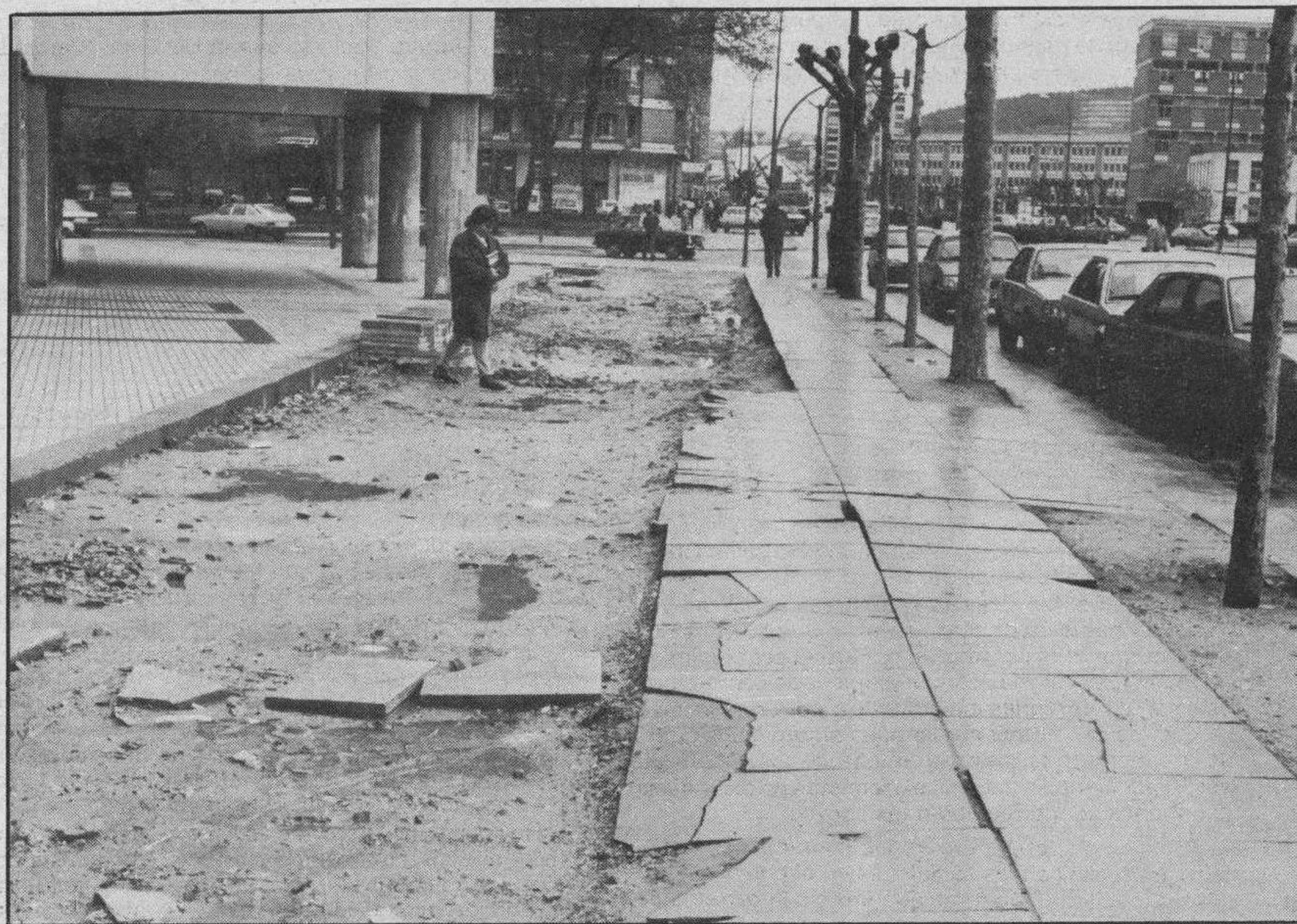
Acera infame. — La foto lo dice todo. En la avenida del general Vigón, una de las aceras más concurridas de peatones ofrece este deplorable aspecto, lo que supone un descrédito para los servicios responsables de la pavimentación, mientras que al otro lado de la avenida también surge idéntico lamento en amplios tramos. Se impone una razonable mejora y lo antes posible.
