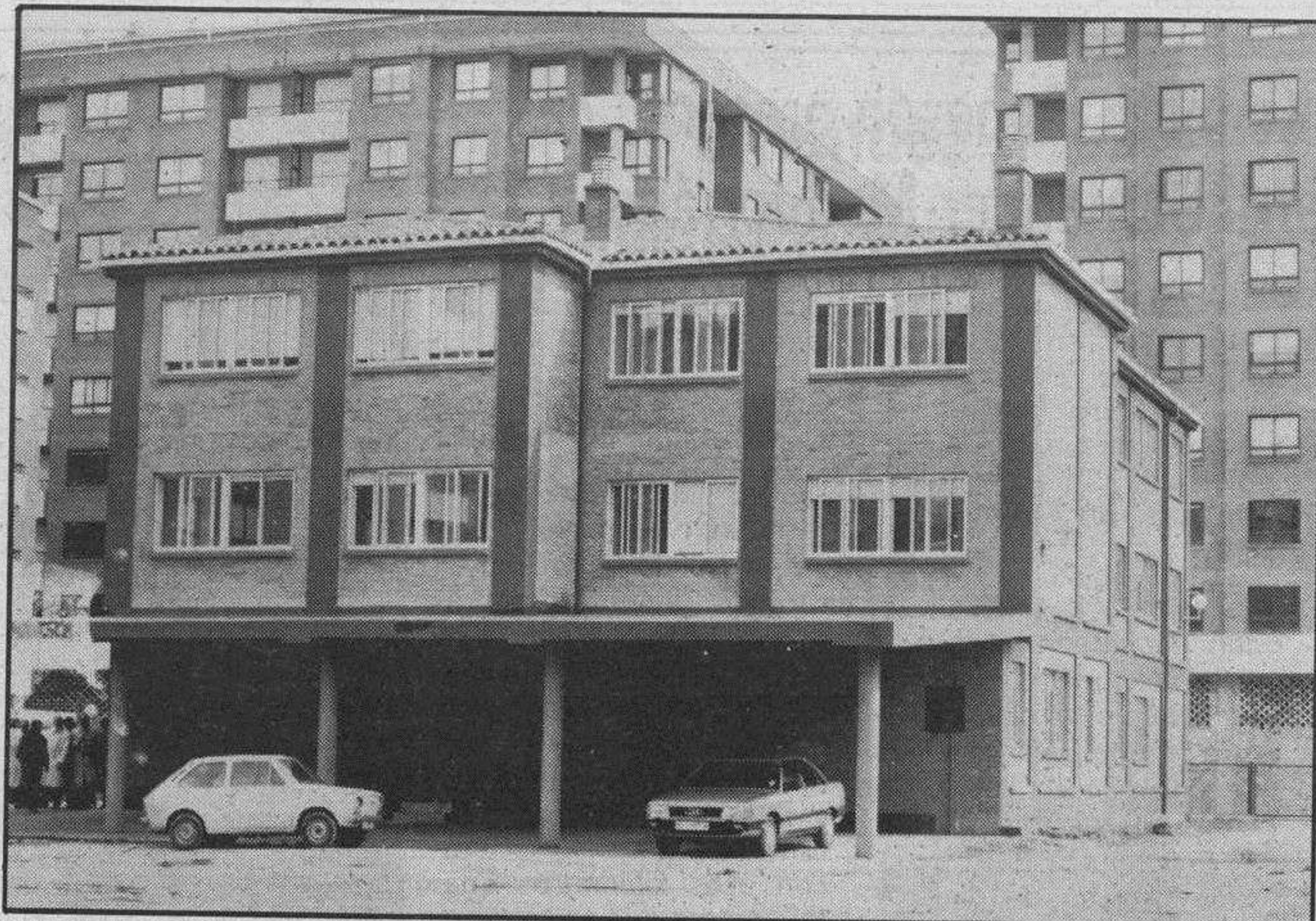
Colegio de EGB construido por «Inmobiliaria Río Vena» y entregado ayer al Ayuntamiento en la persona del alcalde
