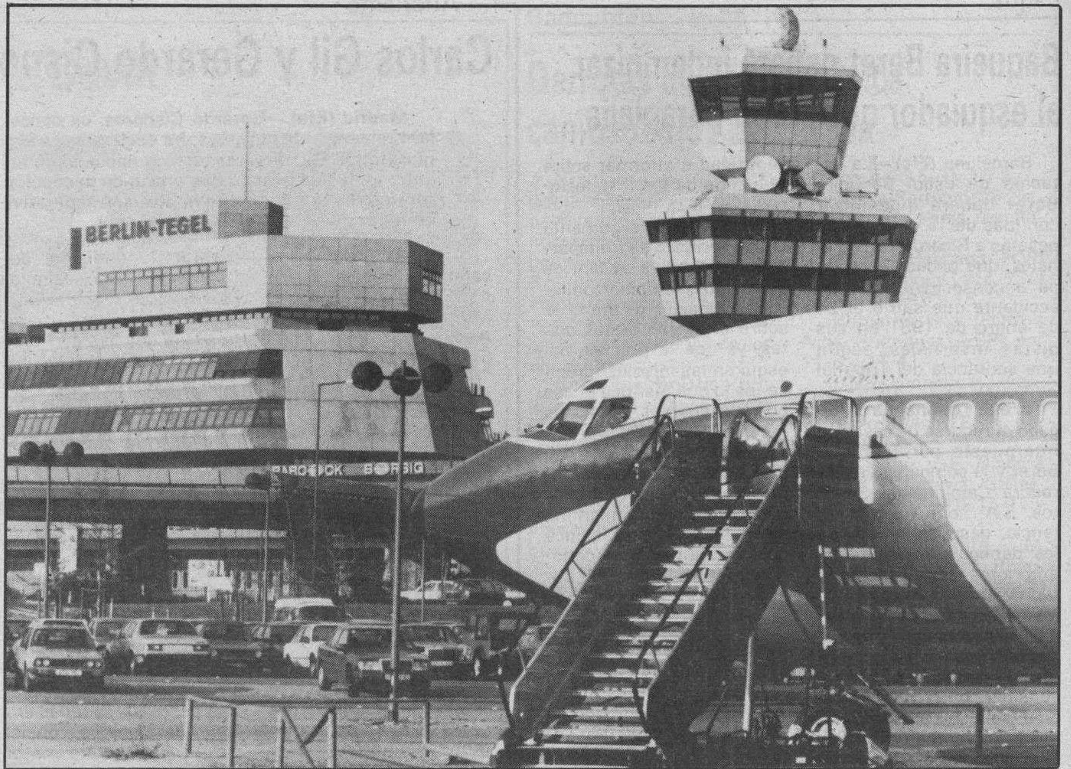
Está siendo ampliado el aeropuerto berlinés de Tegel.— A fin de poder atender el «boom» del tráfico aéreo que se espera en el futuro, están realizándose las correspondientes obras de ampliación del aeropuerto berlinés occidental de Tegel. De aquí a 1991 contará con una edificación anular de andenes para el pasaje. En la segunda fase de ampliación se construirá un segundo edificio de despacho del pasaje y de las valijas.
