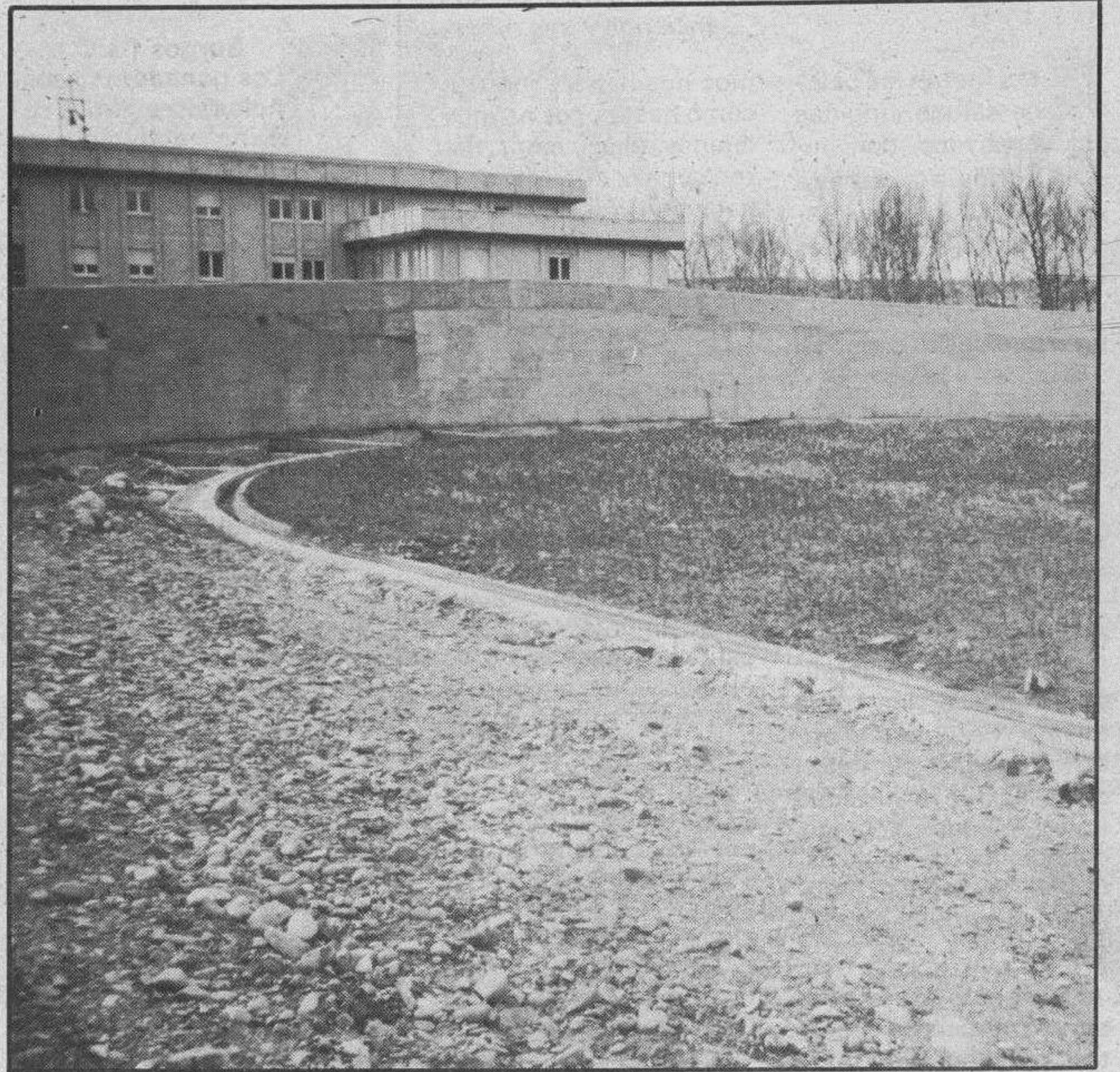
Estado de las obras del velódromo.
