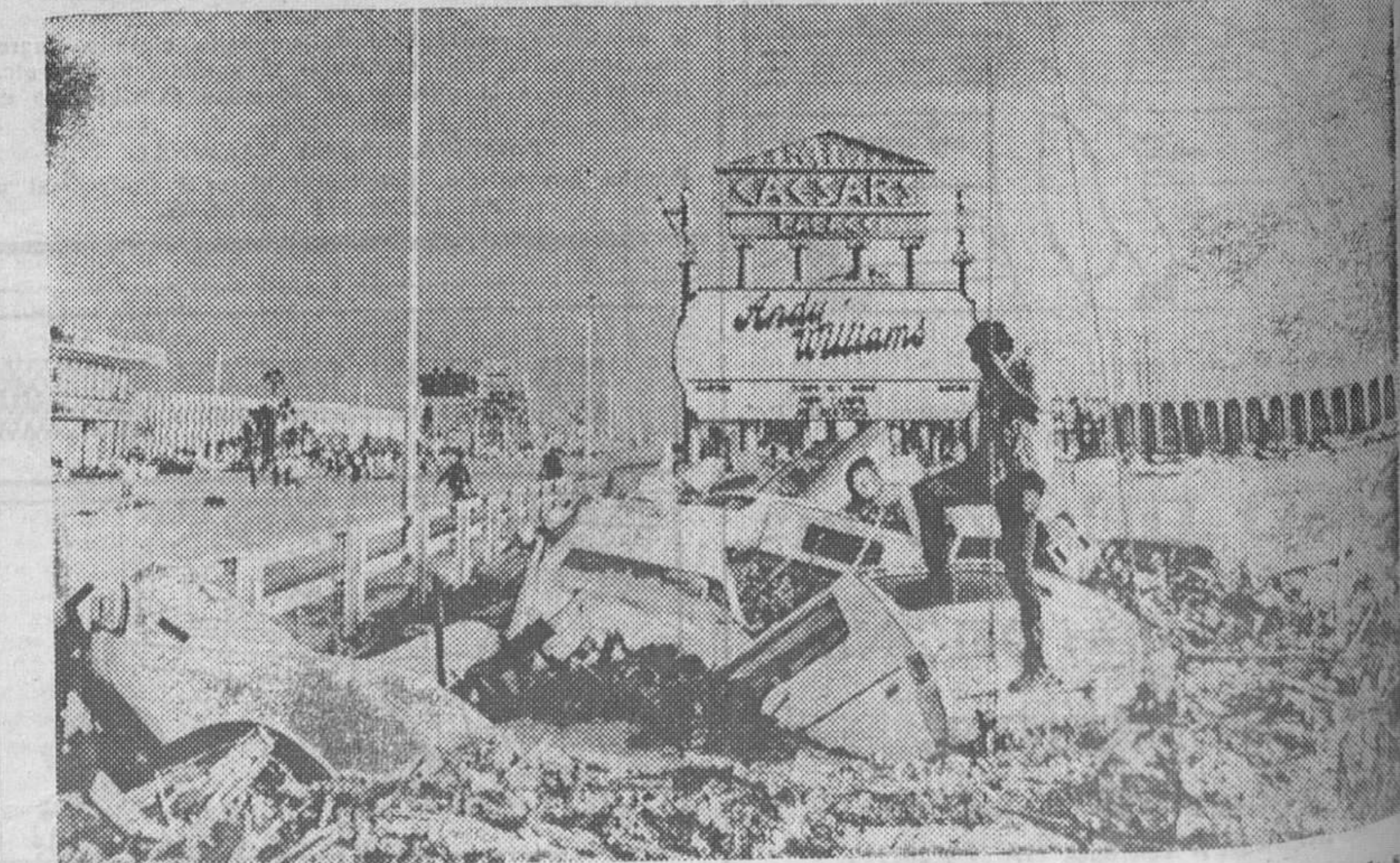
Las Vegas.— La fuerte tormenta que cayó sobre el valle de Las Vegas, desplazó varios coches desde su posición, en un cercano aparcamiento, estrellándolos unos contra otros.— En la fotografía, un empleado dirige los trabajos de la grúa que iba a retirar los coches. Afortunadamente, no se registraron desgracias personales.
