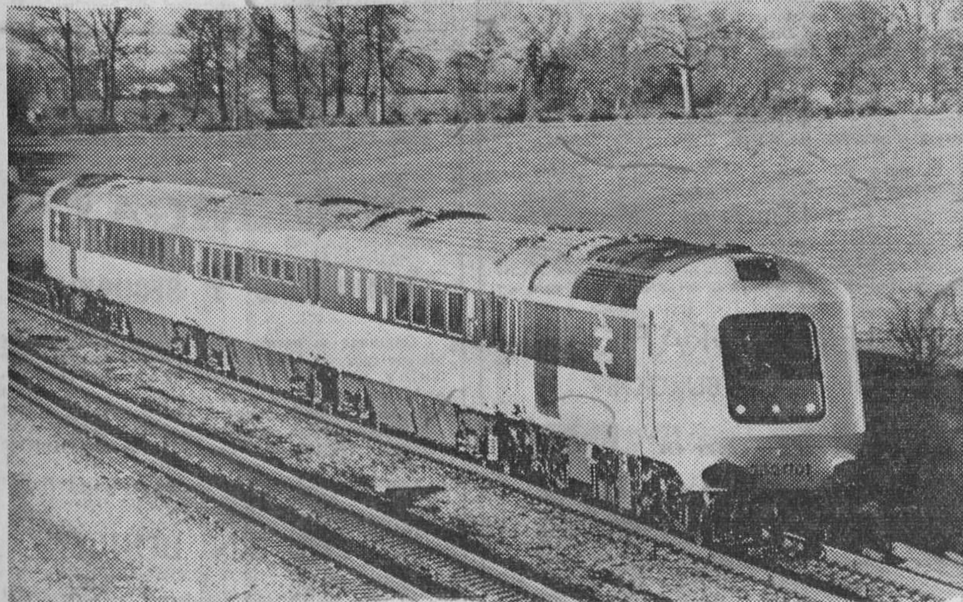
El prototipo de tren de alta velocidad construido por los Ferrocarriles Británicos, capaz de alcanzar las 127 millas por hora es fotografiado durante un viaje de pruebas entre Reading y Swindon. El tren, que ha recorrido ya unas 100.000 millas en viajes de pruebas, no entrará en servicio antes de dos años. — (Foto FIEL)
