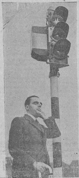
Se ha inventado un dispositivo que, acoplado a los puestos reguladores de tráfico para peatones, transmite las señales de "parada" o "cruce ahora" en forma sonora.
