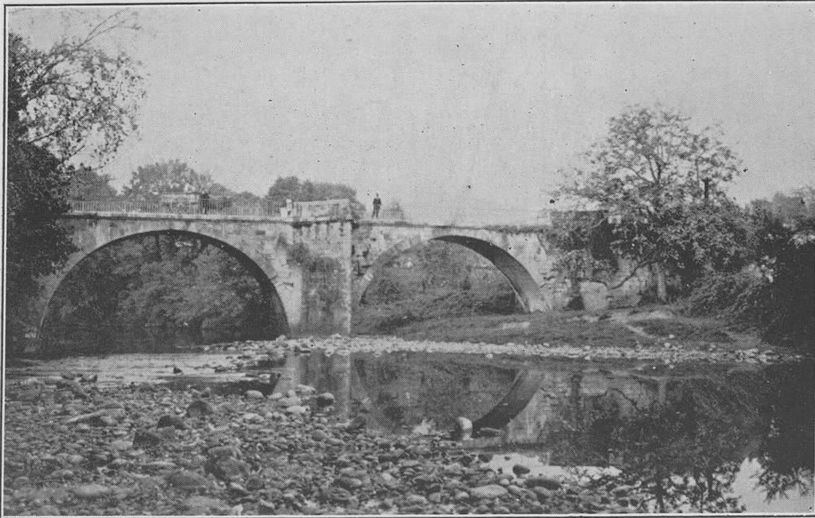
Puente de Solares sobre el río Miera
