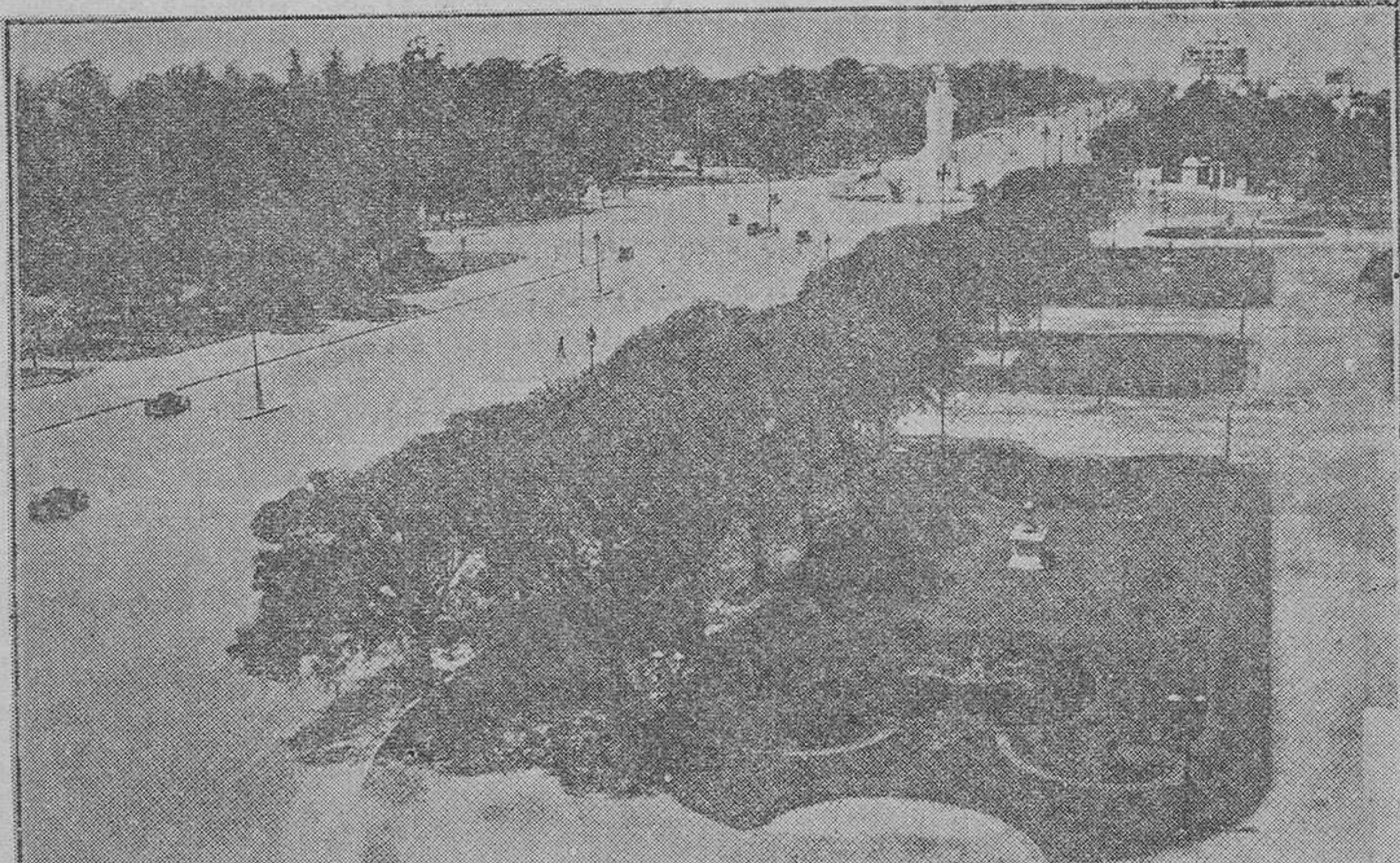
Aspecto panorámico de una parte del lugar donde se realizarán en octubre del año próximo las grandes concentraciones del XXXII Congreso Eucarístico Internacional. Avenida Alvear y Sarmiento y "Monumento de los Españoles" en Palermo (Buenos Aires).
