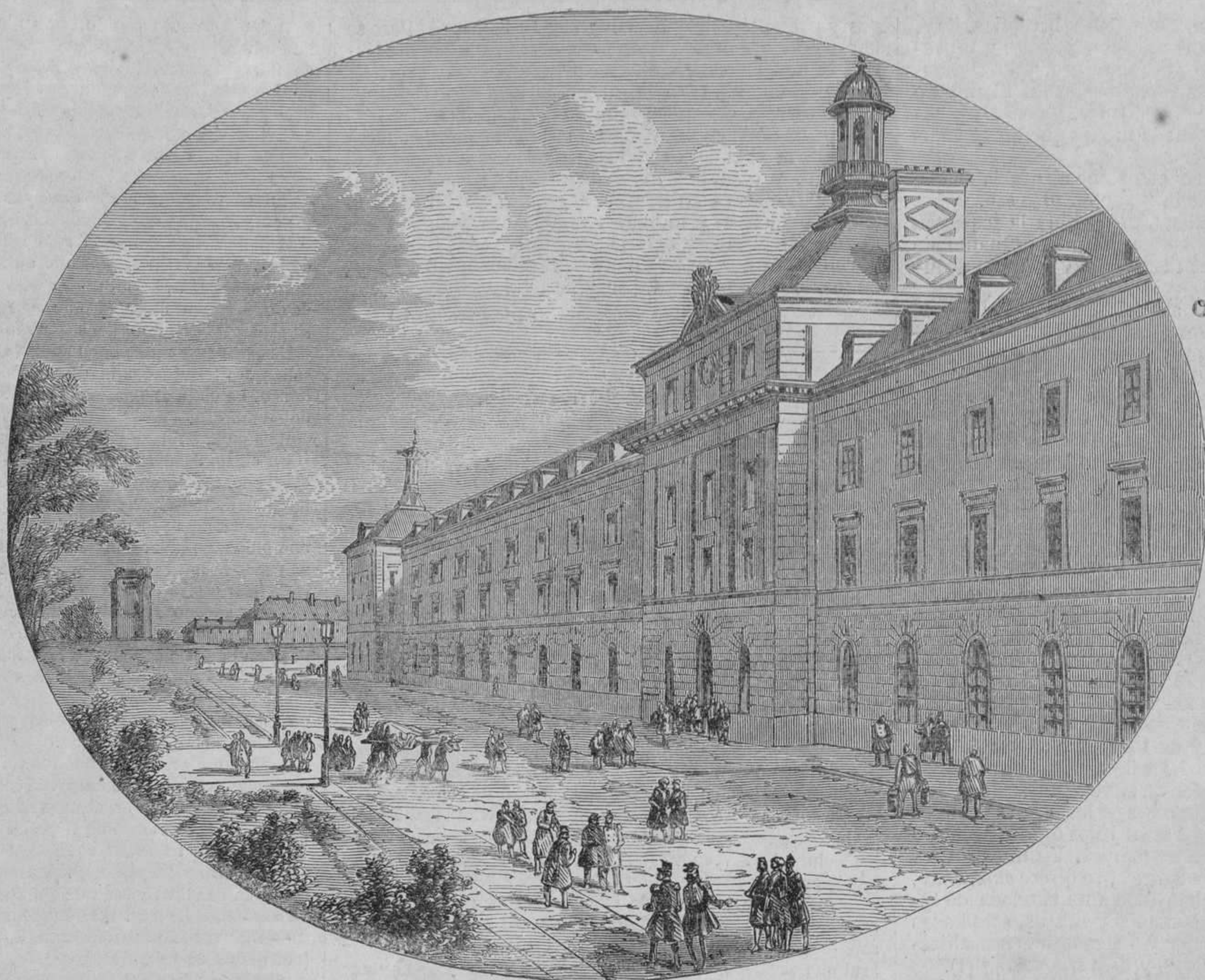
EL HOSPITAL MILITAR DE VINCENNES. — VISTA EXTERIOR DEL PABELLON PRINCIPAL.
