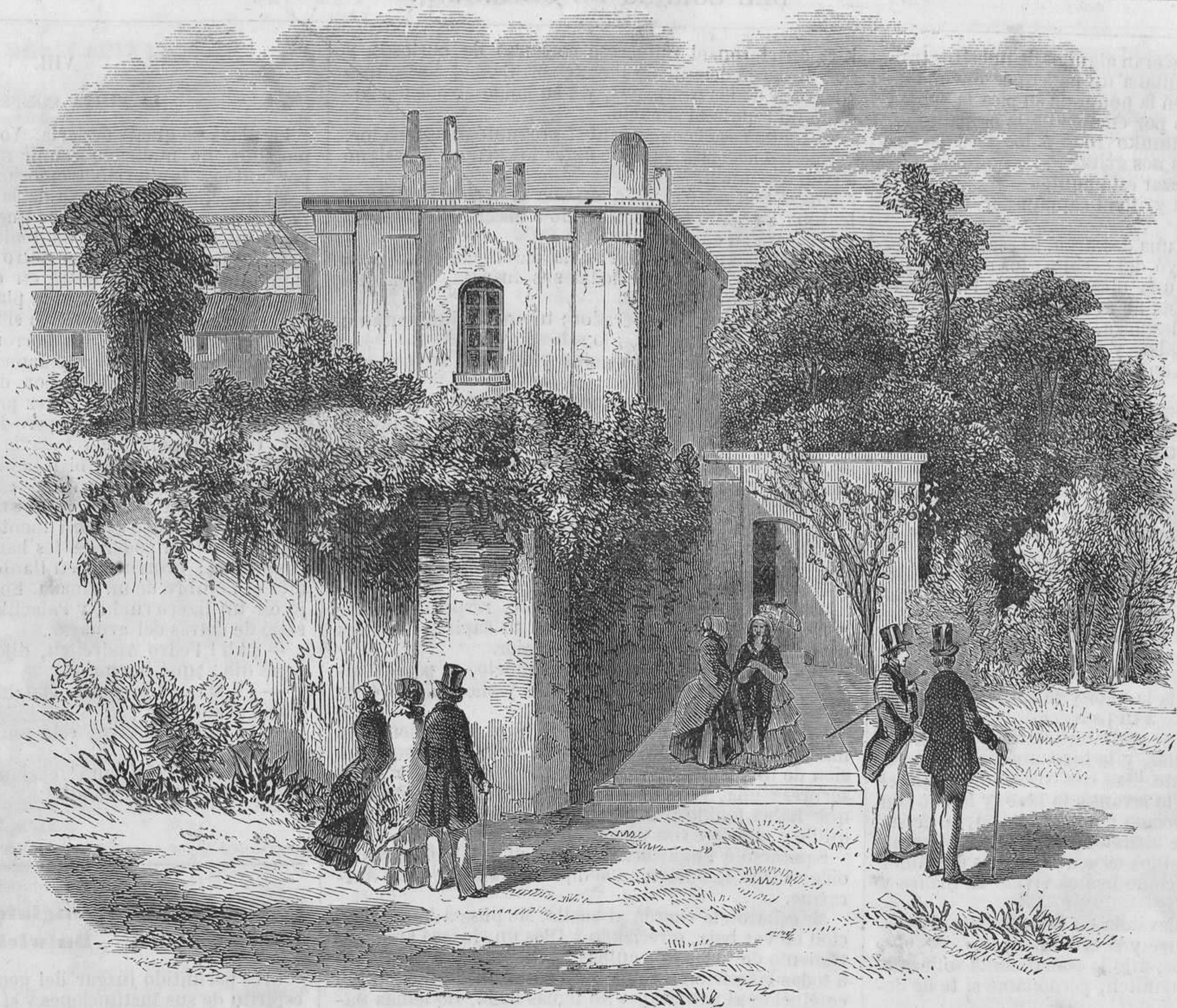
Entrada de la galeria de cuadros de Dulwich, cerca de Londres.
