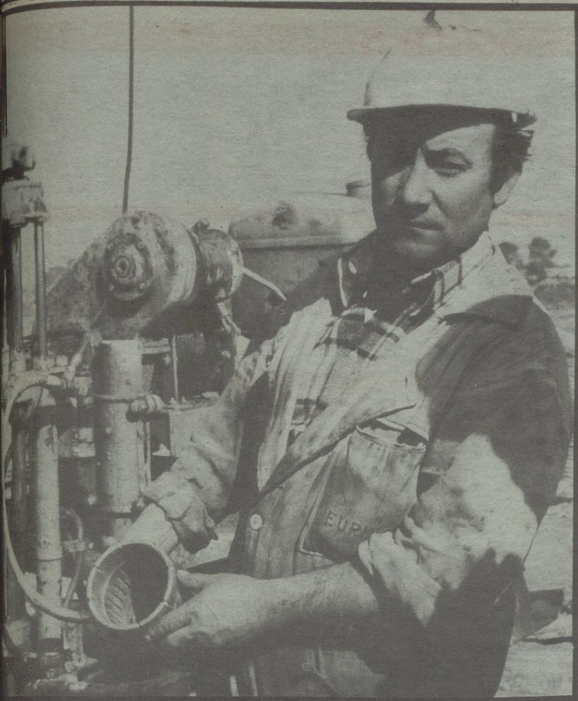
En manos del encargado de los sondeos, uno de los modelos de las "coronas de diamantes" utilizadas, auténticas puntas de lanza de las prospecciones.
