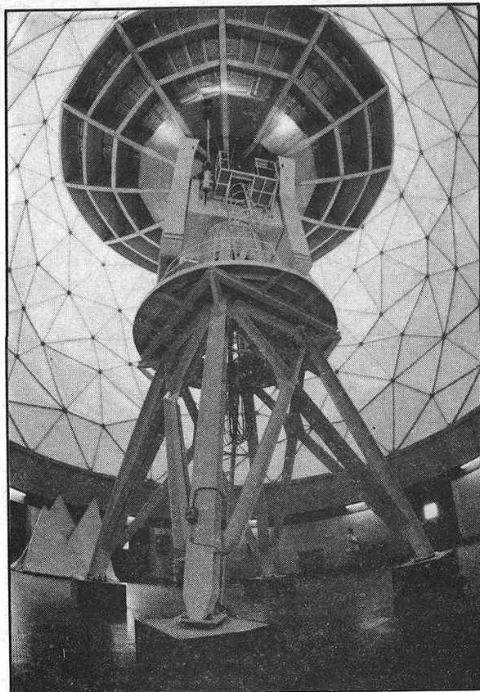
Radiotelescopio de ondas milimétricas, de 13,7 metros de diámetro
