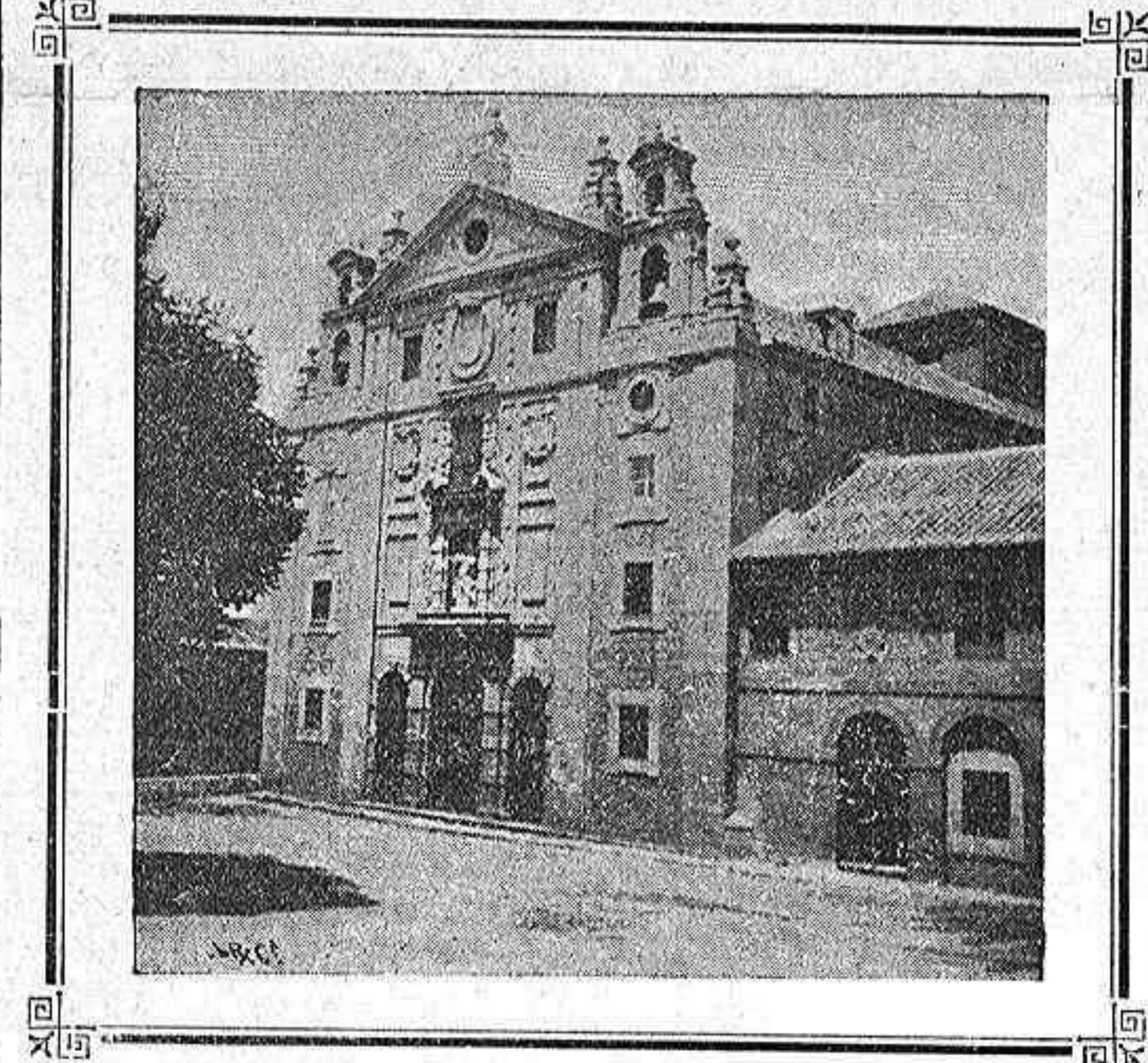
Convento de Santa Teresa, edificado sobre el terreno que ocupó la casa donde la insignie Doctora vió la luz primera.
