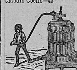
Prensa Hércules, para uvas sistema de palanca múltiple reforzada.
