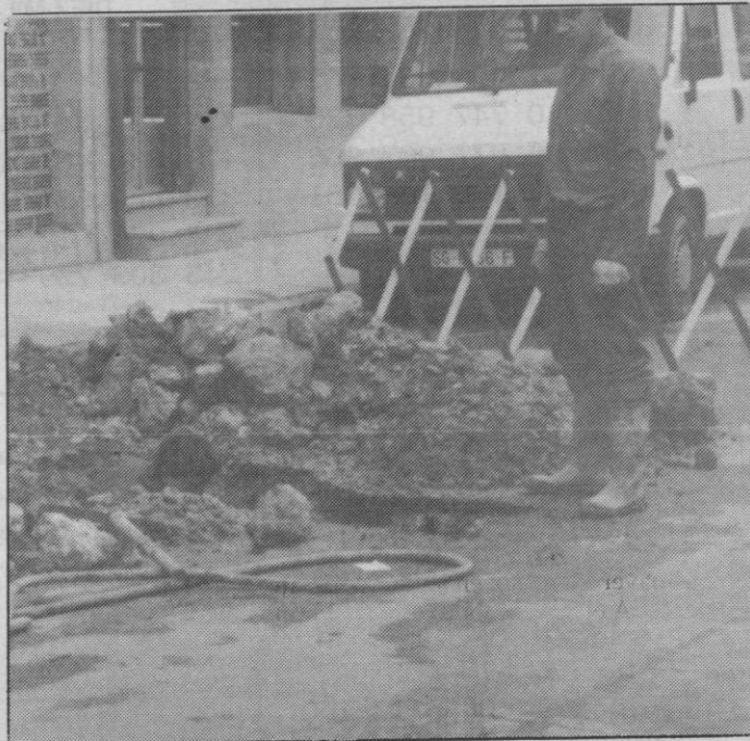
Operarios de Aquagest, realizando reparaciones en tuberías.
