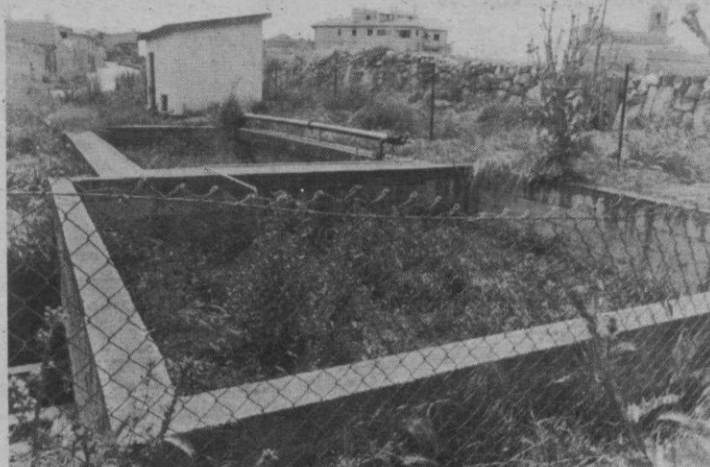
La depuradora sólo funcionó una semana
