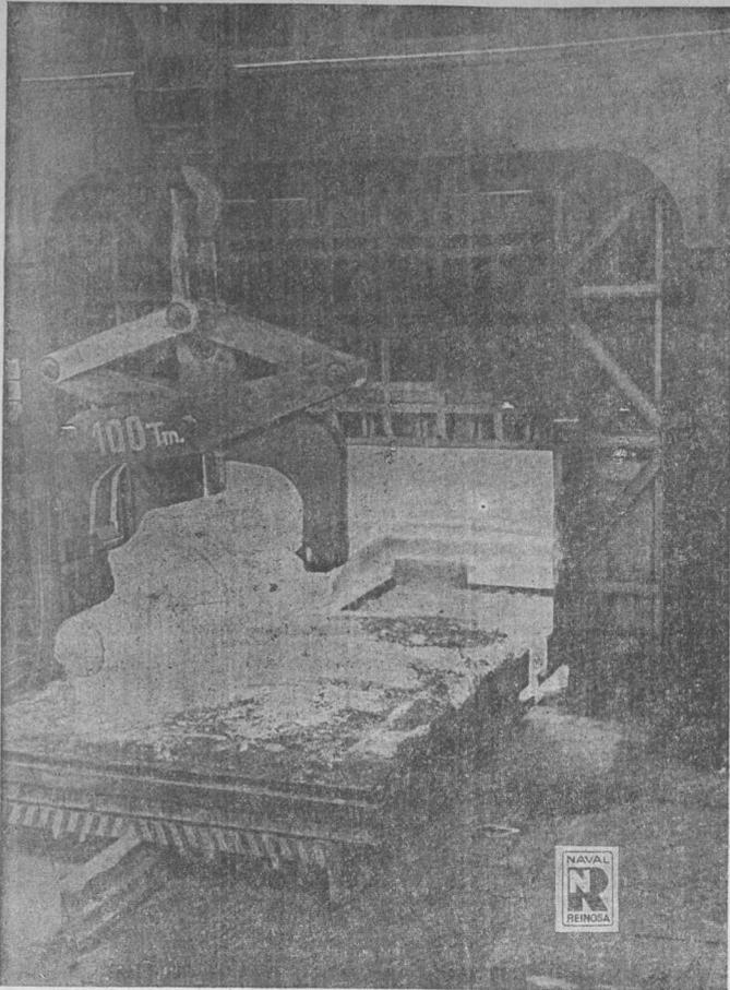
Lingote de 70.000 kilos, saliendo del horno de recalentar, para su forja, con destino a un eje para buque.
