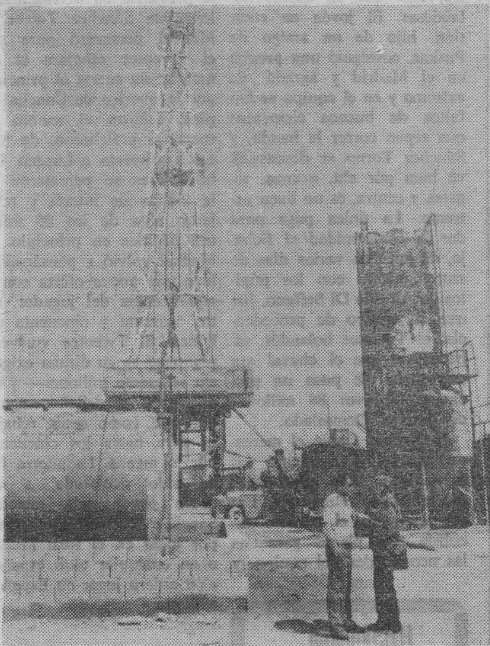
Torreta perforadora en el «Navajo 1». (Foto J. J. PRESA)
