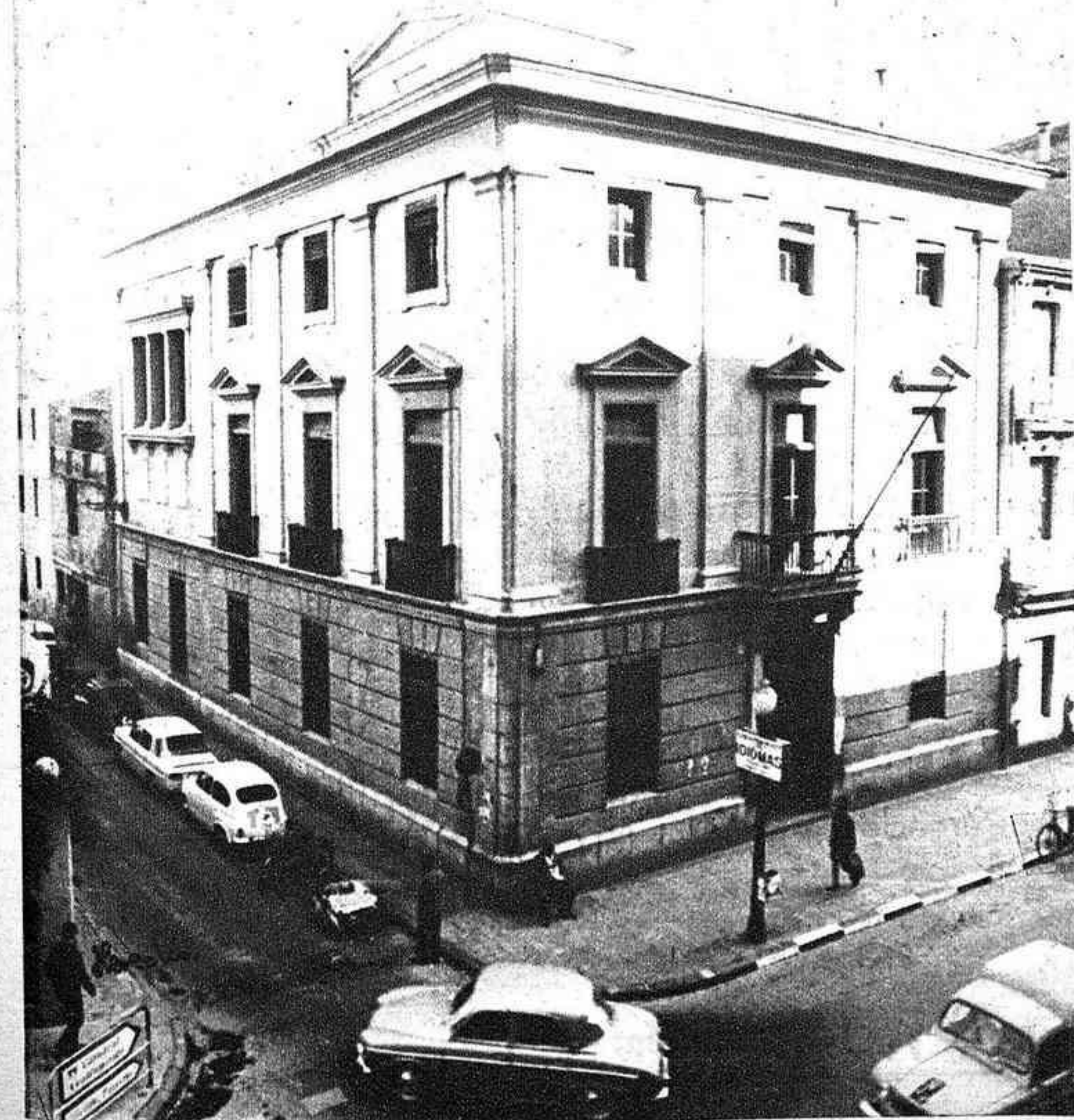
Grupos de edificios adquiridos para la instalación de la casa social
