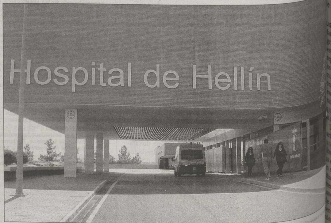
Acceso principal al centro sanitario hellinero. / ÁNGEL ROMERO
