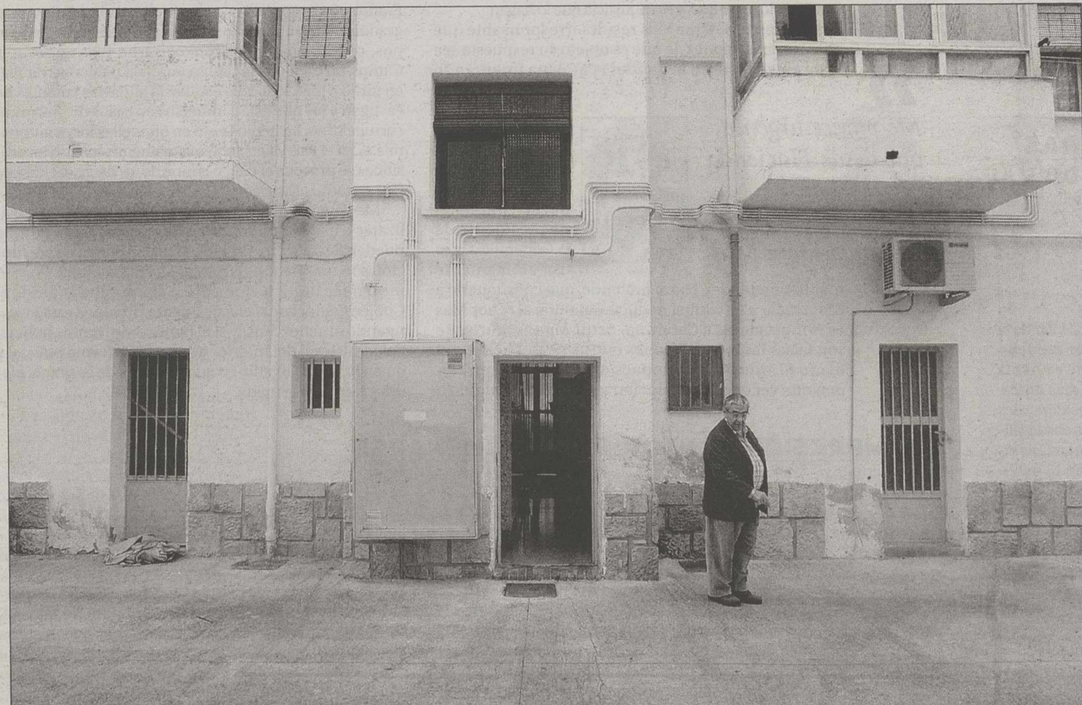
Imagen del patio de luces de la comunidad de vecinos del barrio Pedro Lamata que solicitó la primera licencia. / ARTURO PÉREZ
