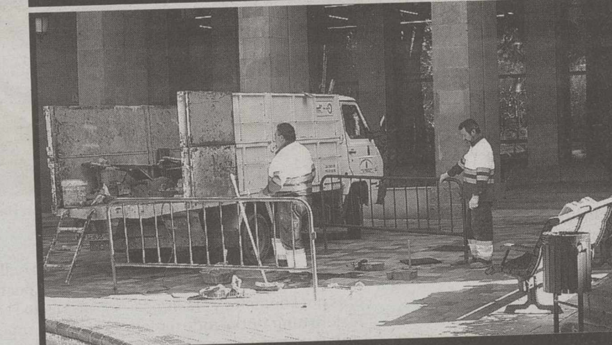
Arreglos en la Plaza del Ayuntamiento. Los equipos de operarios no paran estos días y se encuentran en plena labor, con distintos arreglos y mejoras en la Plaza del Ayuntamiento de Albacete. /R.S.
