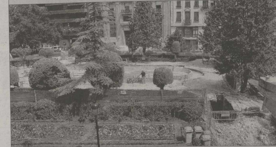
Los refugios al descubierto. Con motivo de las obras de impermeabilización de la fuente del Altozano, se puede observar el estado de los antiguos refugios anti-aéreos que el Ayuntamiento rehabilitará y abrirá al público en breve. / ARTURO PÉREZ
