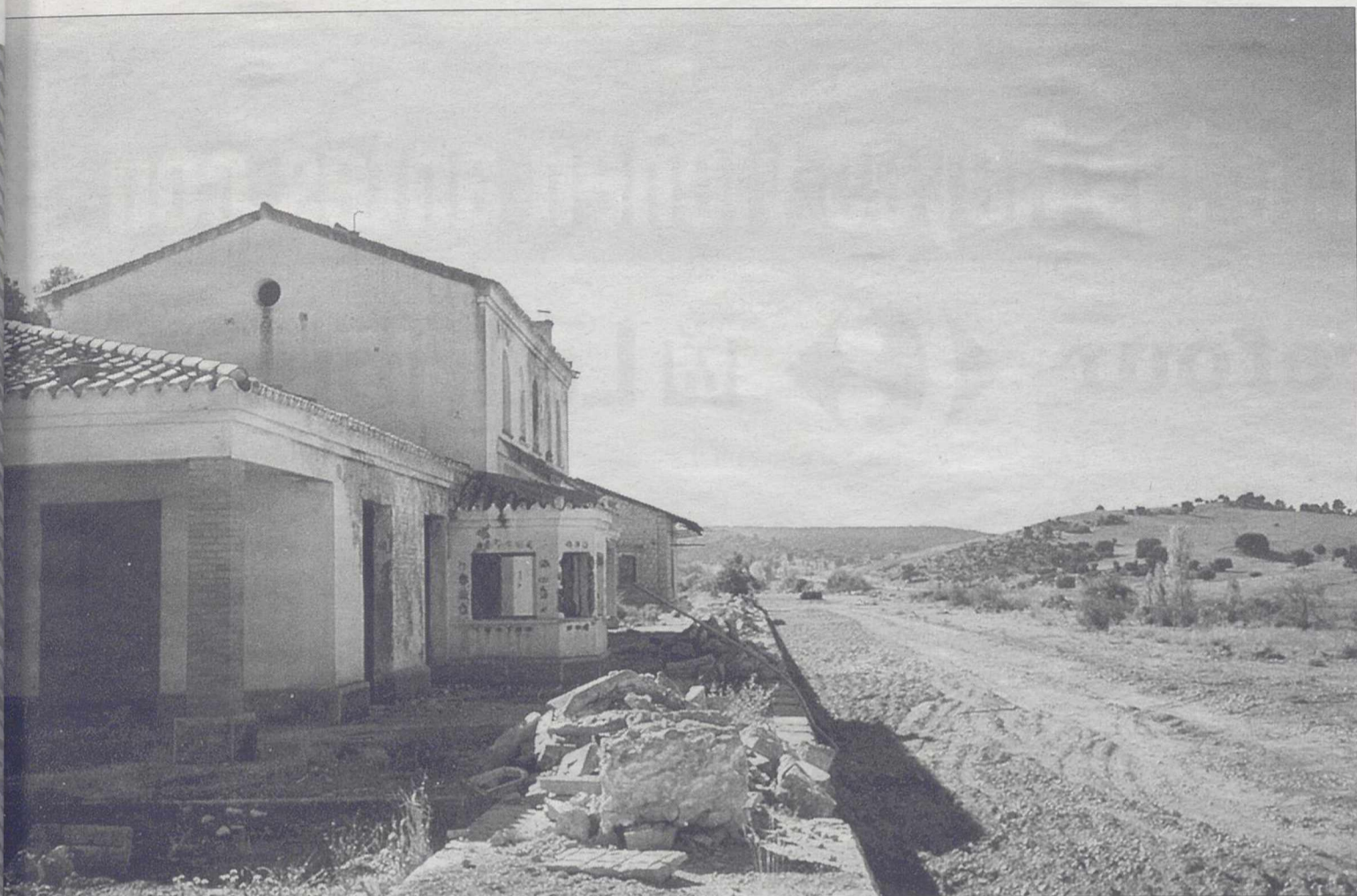
Los edificios en ruina que se encuentran por el camino podrán ser rehabilitados./ LT
