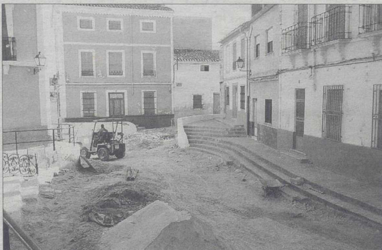
La calle Alfarerías, cuyas obras se llevan a cabo en estos momentos./A. ROMERO
