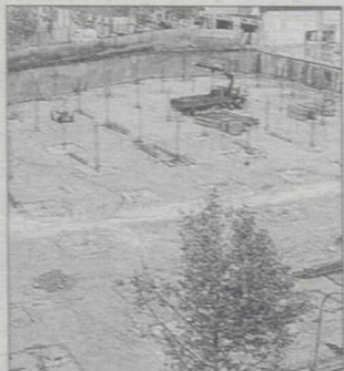
Obras de ampliación.
