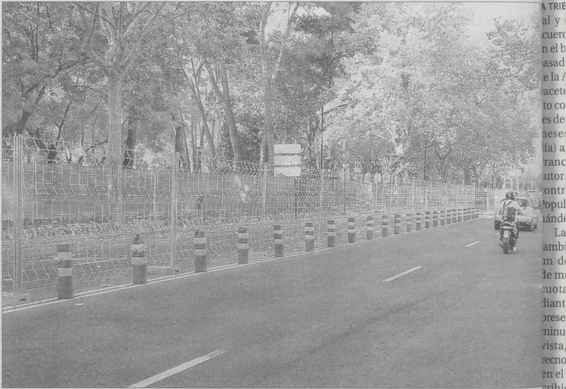
Las obras del aparcamiento van a suponer levantar por completo todo el tramo de la Avenida de España.
