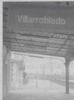
Estación de Villarrobledo.
