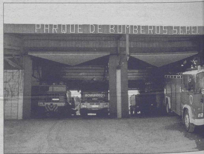
Instalaciones actuales del S.E.P.E.I. en Hellín./LA TRIBUNA
