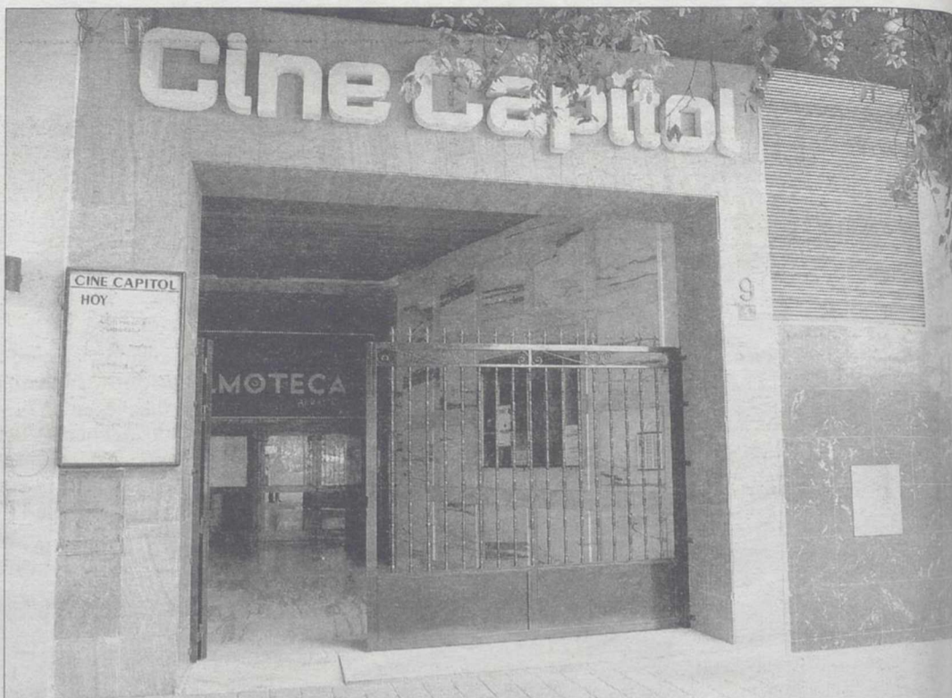
La entrada del cine, que también lo es de la comunidad de vecinos, se ve restringida por la instalación de la valla.
