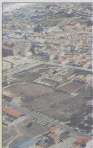
Solar donde se construirá.
