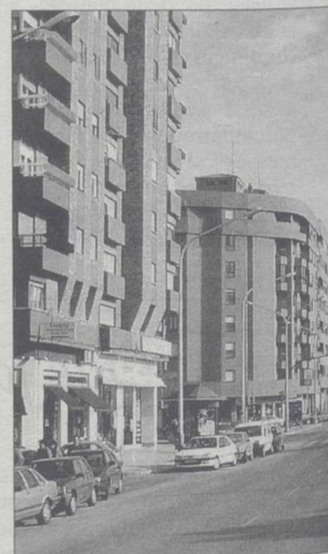
Carretera de Circunvalación. / LT
