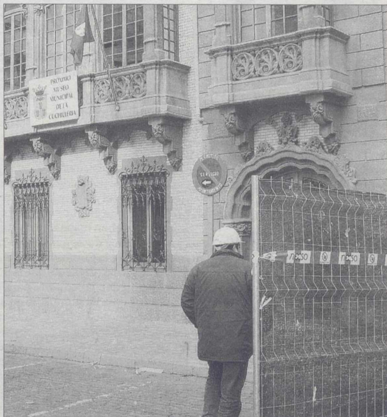
Durante los próximos cinco meses la Casa de Hortelano estará en obras./C.LOPEZ
