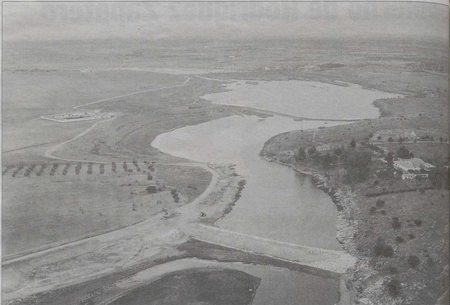
Los promotores del proyecto han construido una pequeña presa para mantener una lámina de agua constante en la zona de cola del embalse. / C.H.G.
