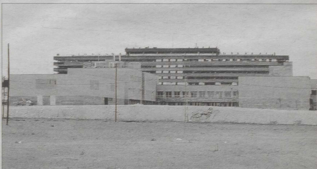
Junto a la Facultad de Medicina se construirá el centro de salud Zona I, que sustituirá al CAS. /LT
