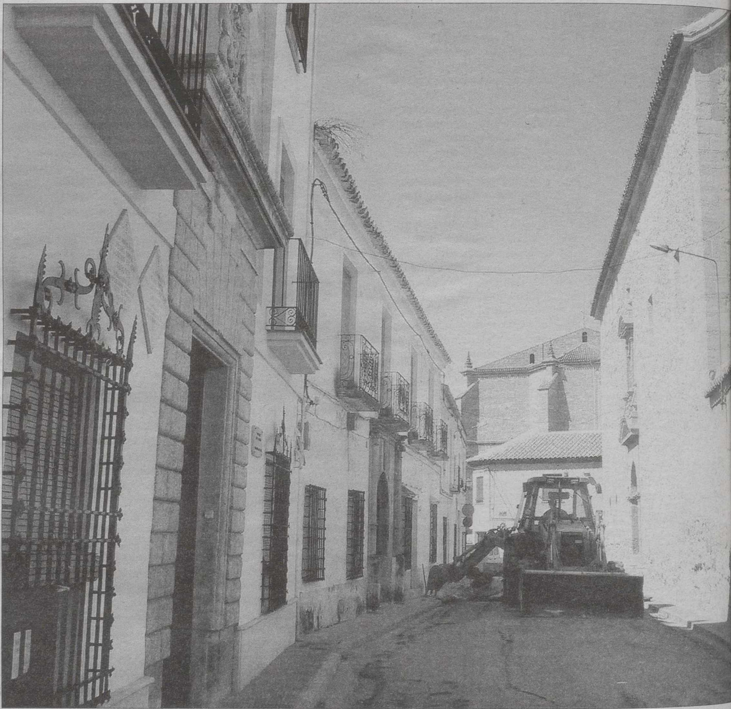
Los vecinos de la calle Pedregal han sido informados para evitar posibles molestias por las obras. /TERESA JIMÉNEZ
