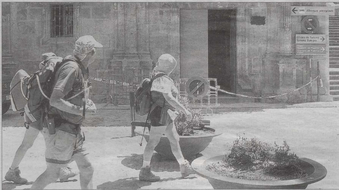
Un grupo de peregrinos observa los daños causados en la fachada del Juzgado de Estella (Navarra). / VILLAR LÓPEZ (EFE)
