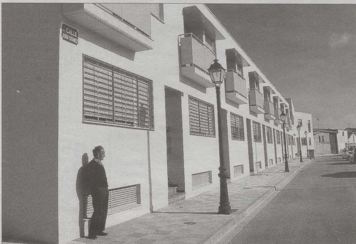
Las viviendas son de tipo dúplex, contando con el garaje en la planta sótano/ARTURO PEREZ
