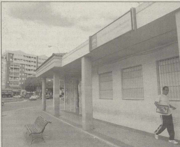
Fachada del IES "San Sebastián" de Huelva.
