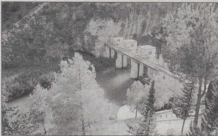
Presa de la Mancomunidad del Taibilla.
