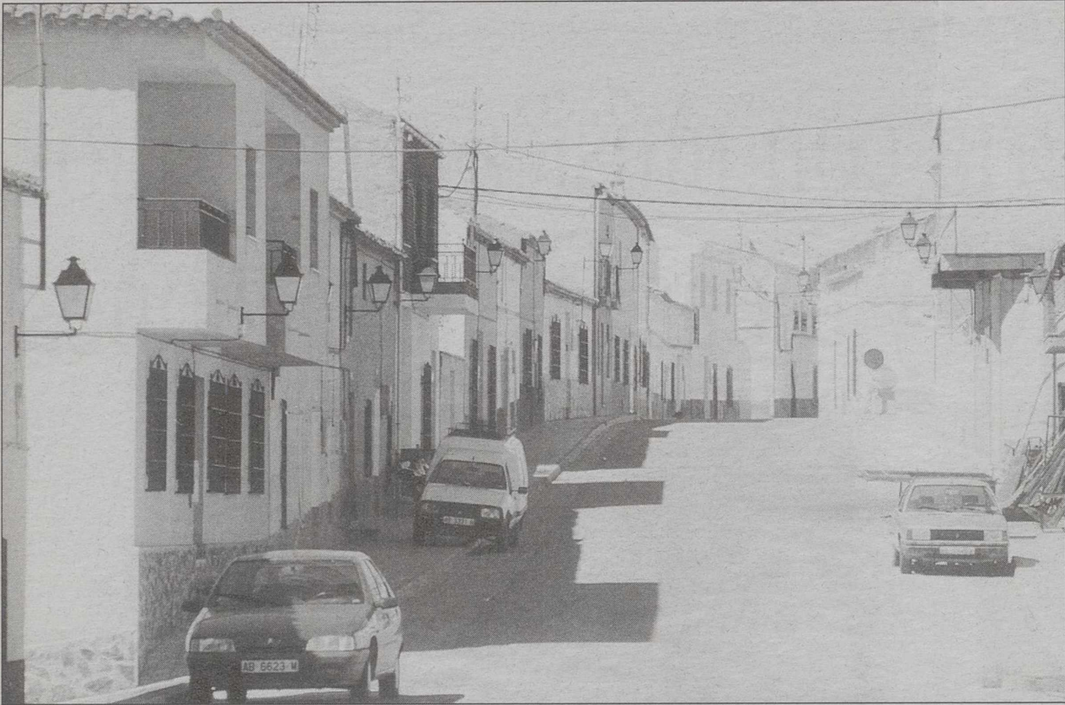
Las reformas programadas afectarán a 6.500 personas que verán mejorada la eficiencia y la seguridad eléctrica.
