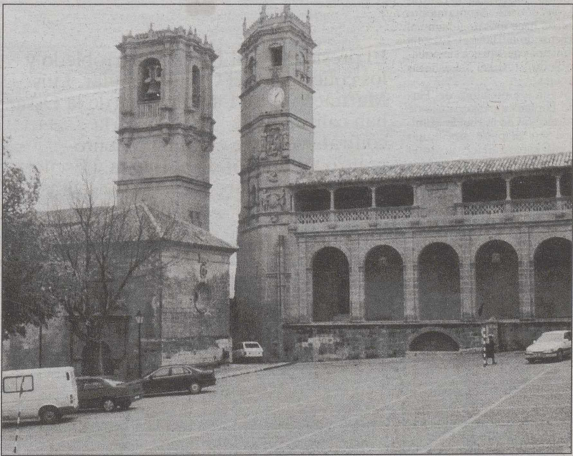
Las obras de mejora supondrán una inversión superior a los 37 millones de pesetas.
