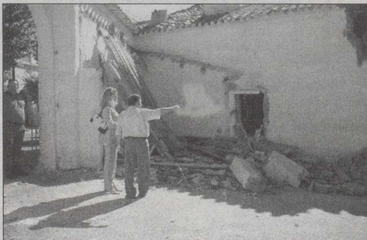
La subdelegada y el alcalde visitaron las obras.
