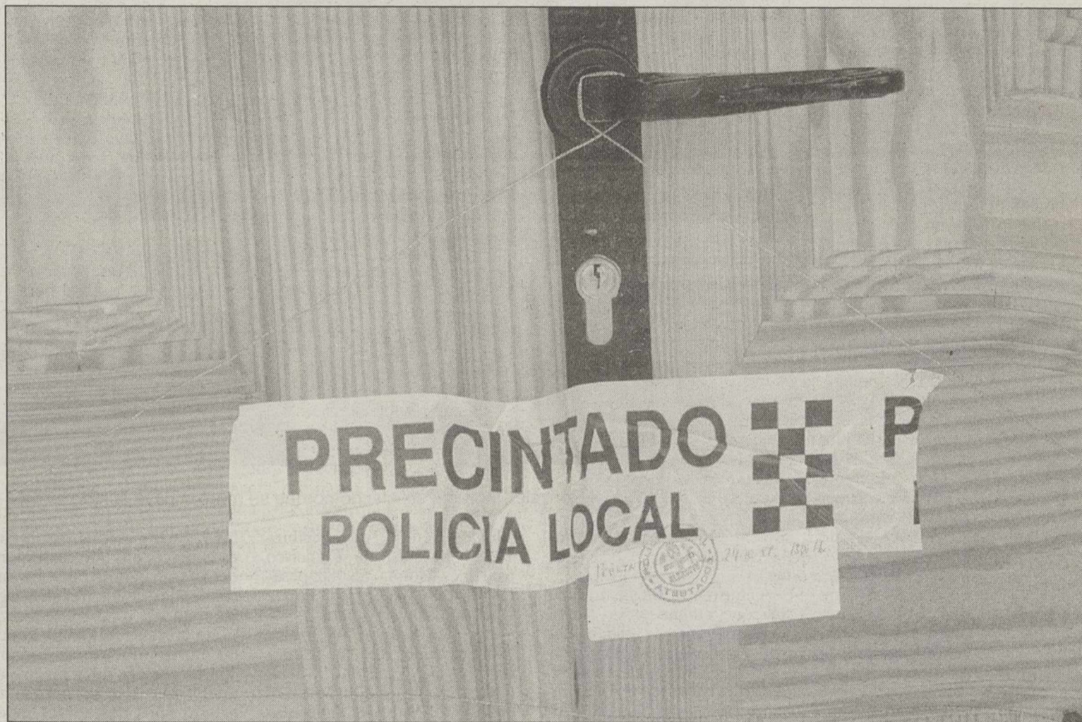
Los servicios de inspección siguen precintando construcciones ilegales en la ciudad.
