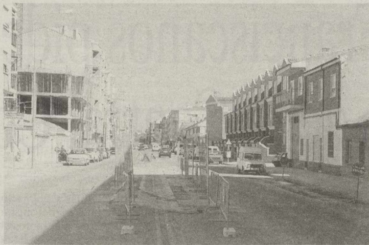
La carretera de Jaén cambiará de aspecto.
