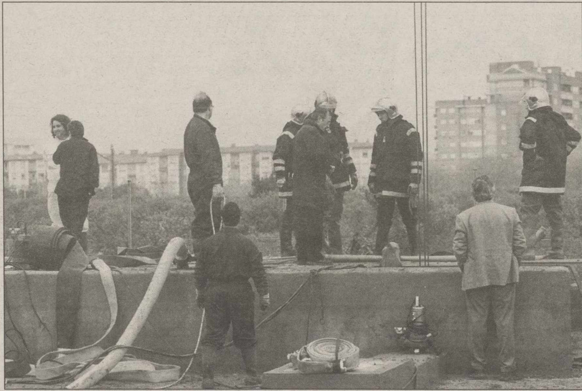
Bomberos y personal de Renfe en Castellón tratan de achicar el agua caída en las vías.
