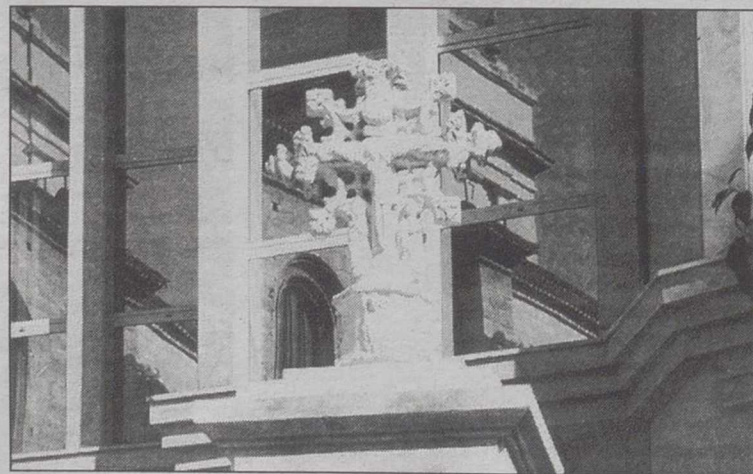
La réplica de la Cruz de Término se irá a la calle de la Cruz.
