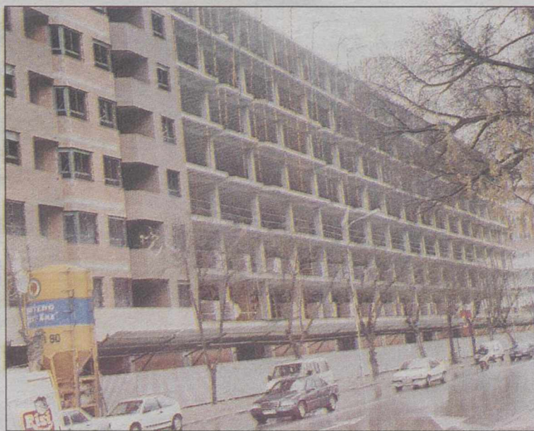
Para evitar los riesgos laborales durante la construcción.
