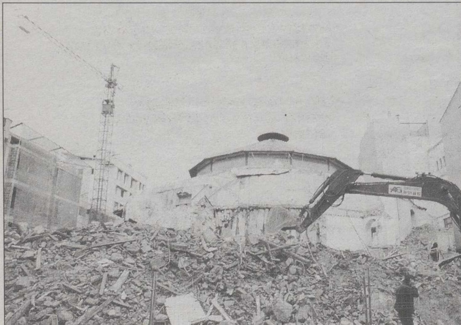
Los trabajos de demolición comenzaron a principios de noviembre.
