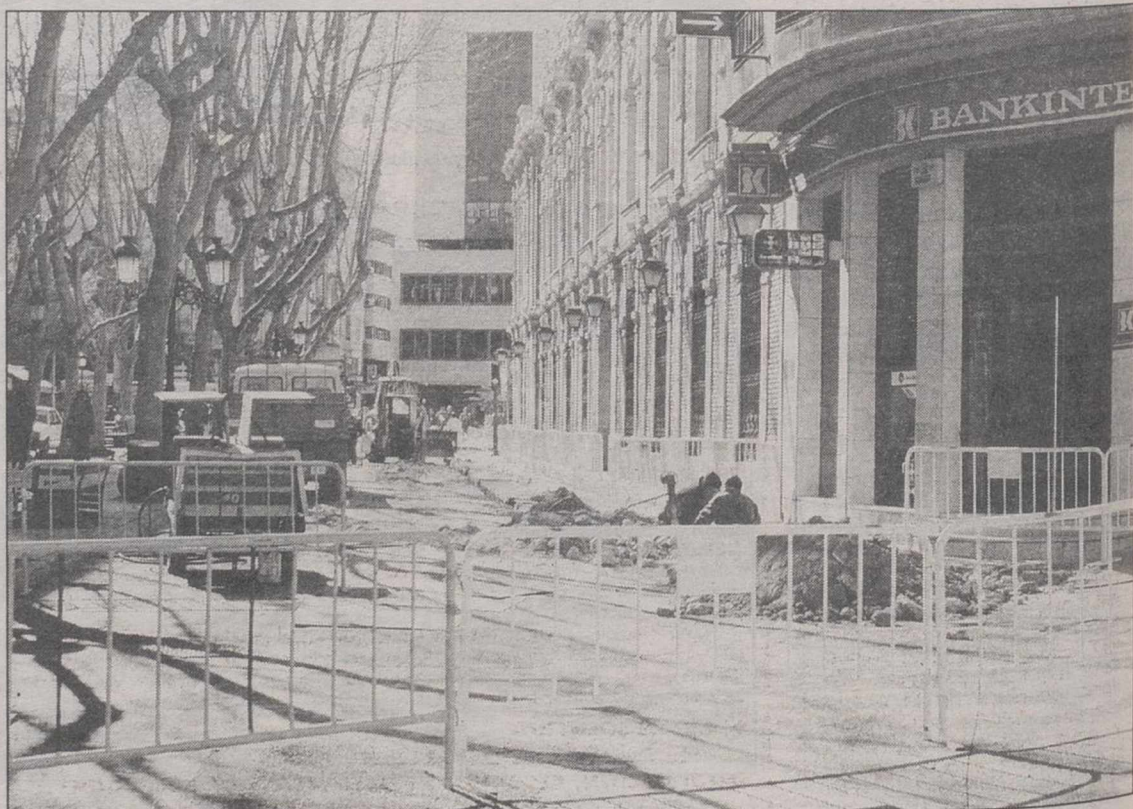
ONO continúa abriendo calles para instalar la red de fibra óptica.
