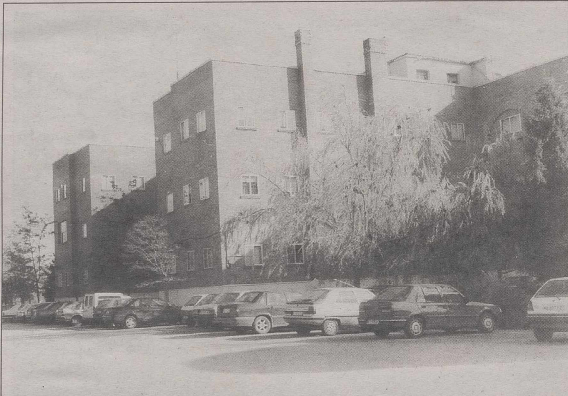
La empresa dispone de cuatro meses para la rehabilitación del Hospital que albergará la URR.
