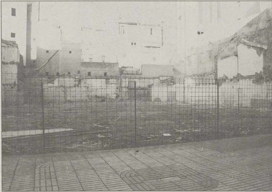
Obras del parking en el número 7 de la calle Concepción.
